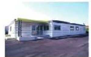
Projet service IRM dans structure modulaire
